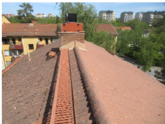
Yttertak belagda med betongpannor
