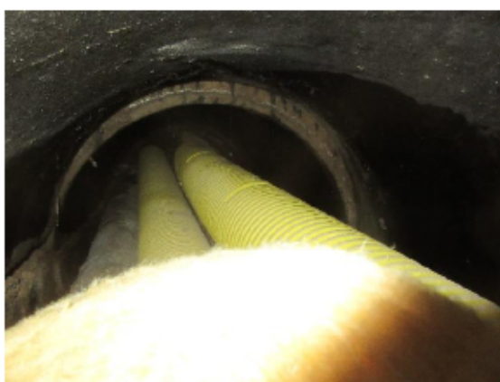
Kulvert mellan byggnaderna
