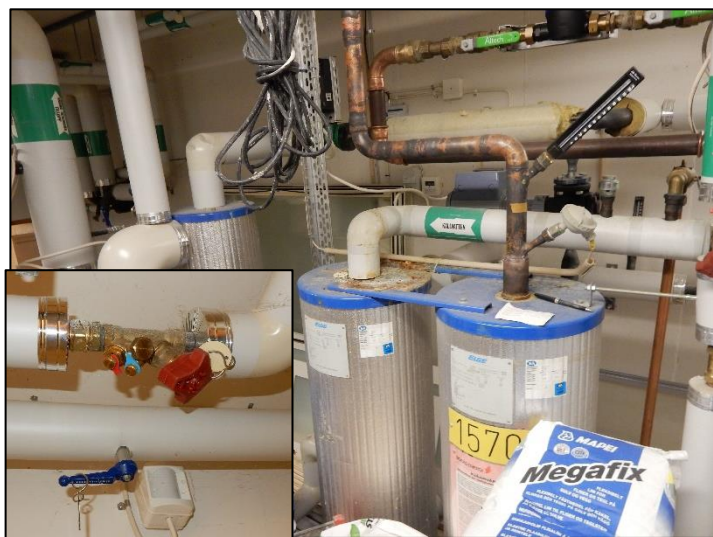
Ventiler till värmeledningar
