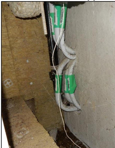
Tappvattenledningar i vvs-schakt på fasad – inkommande vatten
