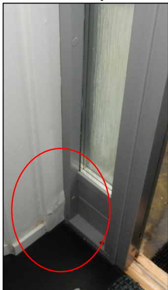
Fuktigenomträngning ytterdörrparti
