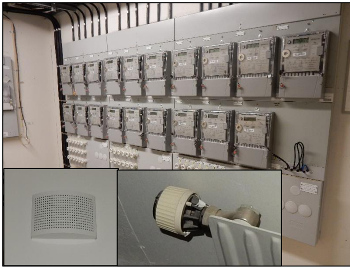
Tilluftsdon och termostat i lgh
