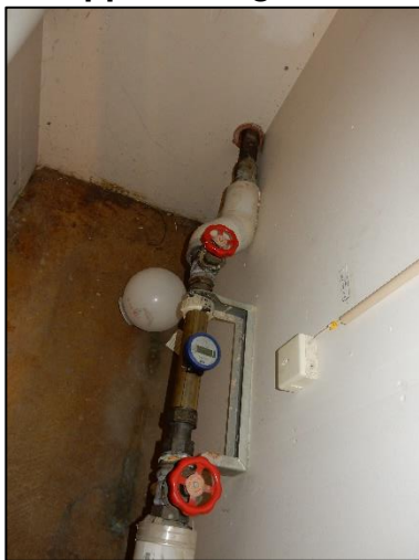
Tappvattenledningar i vvs-schakt på fasad – inkommande vatten
