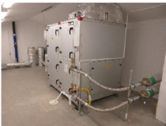
Värmepump för återvinning av frånluften
