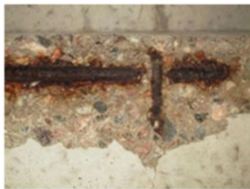
Exempel på skadad balkong. OBS! Annat objekt!
