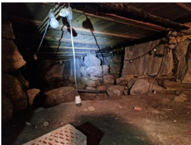
Vy i krypgrund
