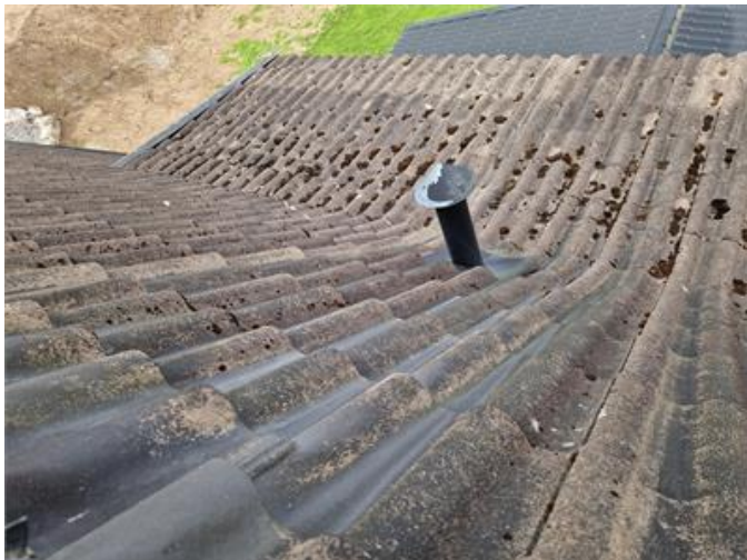
Vy på yttertak
