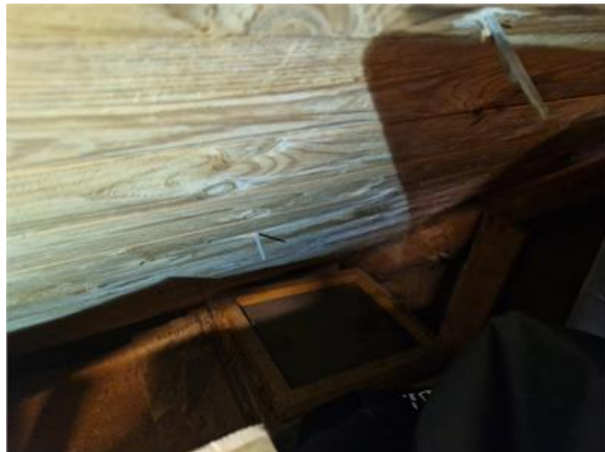
Vy på underlagstak
