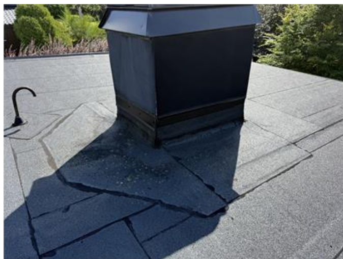
Översiktsbild yttertak invid skorsten
