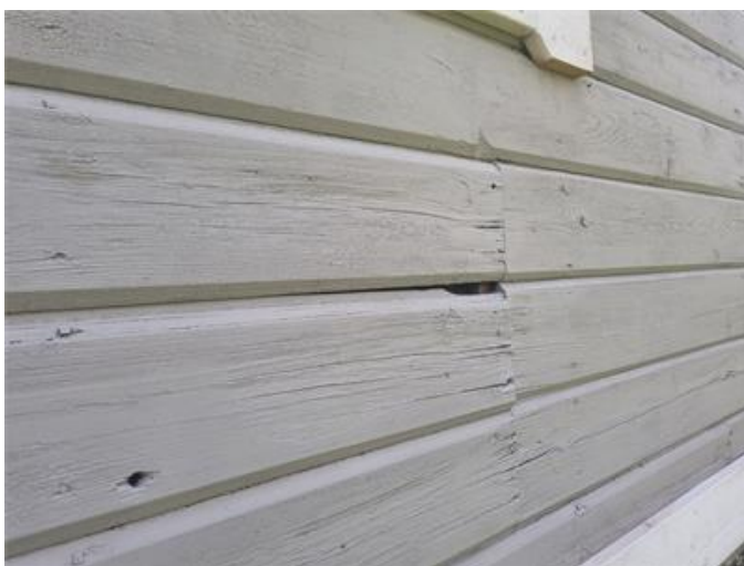
Exempelbild, otätheter och målning/underhållsbehov, fasad.
