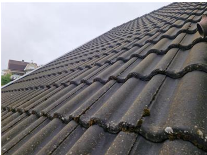
Vy på yttertak
