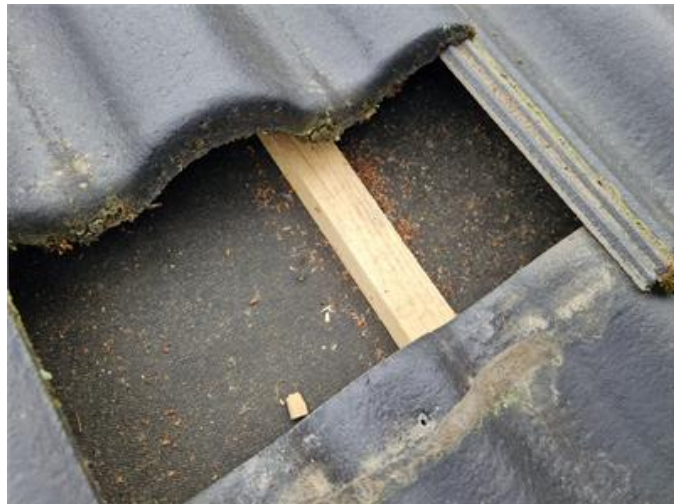
Vy på underlagstak
