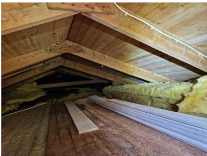
Vy på vindsutrymme
