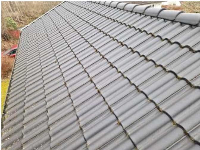
Vy på yttertak
