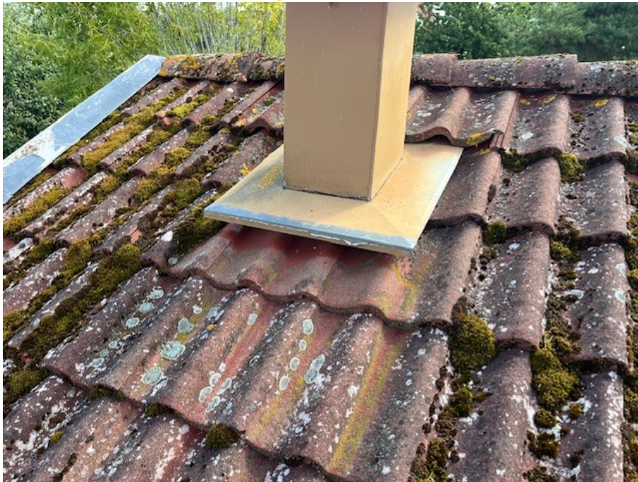
Plåtinklädnad kring ventilationshuv på tillbyggnad.
