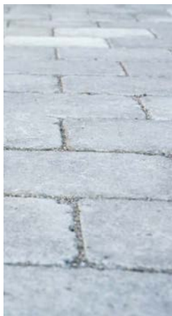
4. Gång och uteplats samt yta framför varmförråd på entrésida
