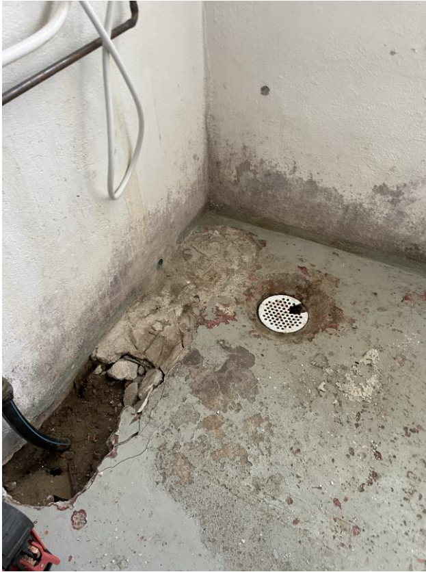
Figur 5. Ej färdigställt dusch/WC
