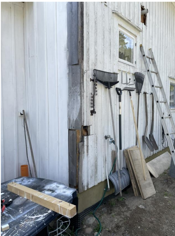
Figur 4. Ej färdigställd fasad.
