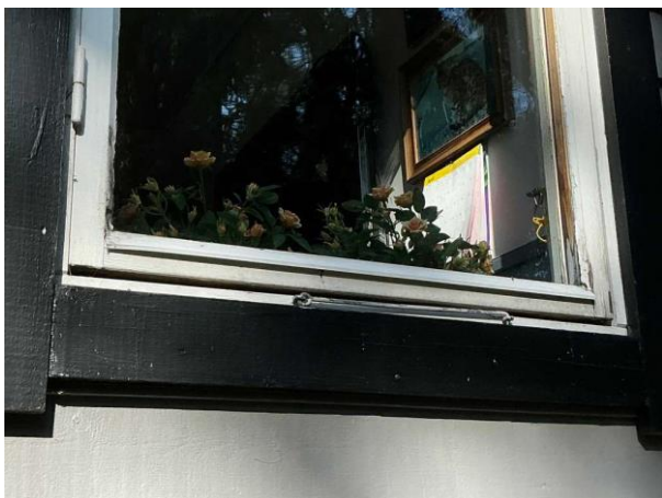
Bild 5: Utvändigt, Fönster, Färgsläpp noterades på fönster Överbleck saknas ovan fönster Kittsläpp noterades Fönsterbleck saknas se riskanalysen
