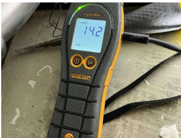
Bild 8: - Invändigt, Soutterrängplan, Fuktkontroll utförd under gränsvärde se bilaga 4
