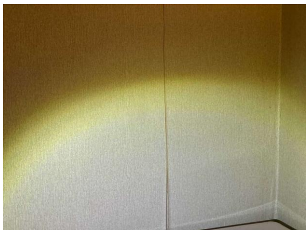
Bild 9: - Invändigt, Soutterrängplan, Äldre våtrum lös tapetskarv noteras på väggarna
