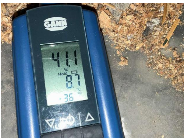
Bild 5: - Utvändigt, Grund, Utluftventilerad kryppgrund Fuktkontroll utförd under gränsvärde se bilaga 4
