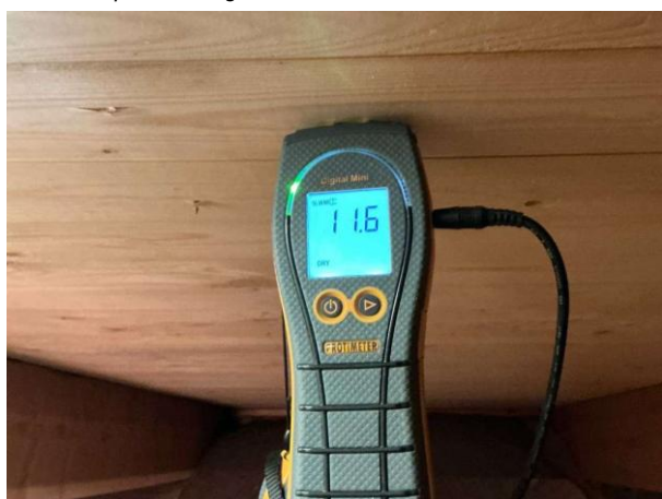
Bild 11: - Utvändigt, Vind, Fuktkontroll utförd under gränsvärde se bilaga 4
