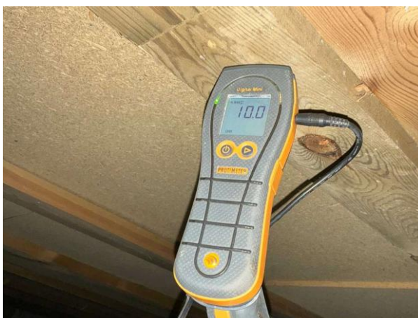
Bild 6: - Utvändigt, Grund, Utluftventilerad kryppgrund Fuktkontroll utförd under gränsvärde se bilaga 4
