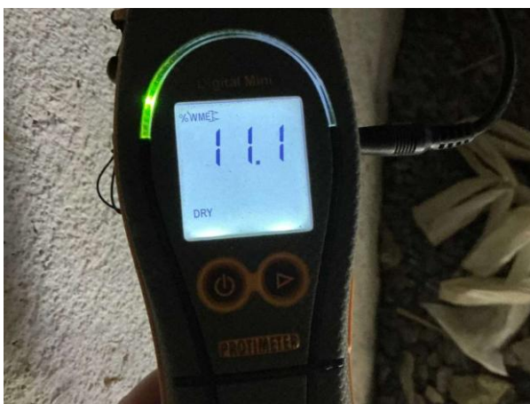
Bild 4: - Utvändigt, Grund, Utluftventilerad kryppgrund Fuktkontroll utförd under gränsvärde se bilaga 4
