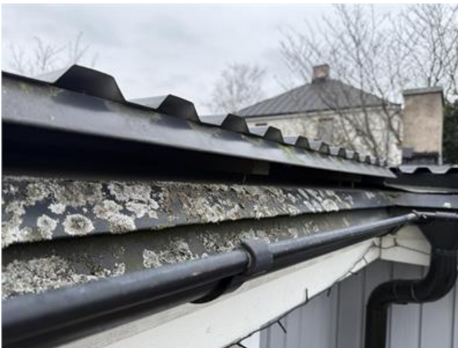
Läkten har lokalt glidit upp längst ner på lägre takdel.
