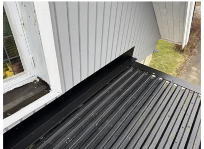
Beslagsplåt monterad på fasadens utsida.
