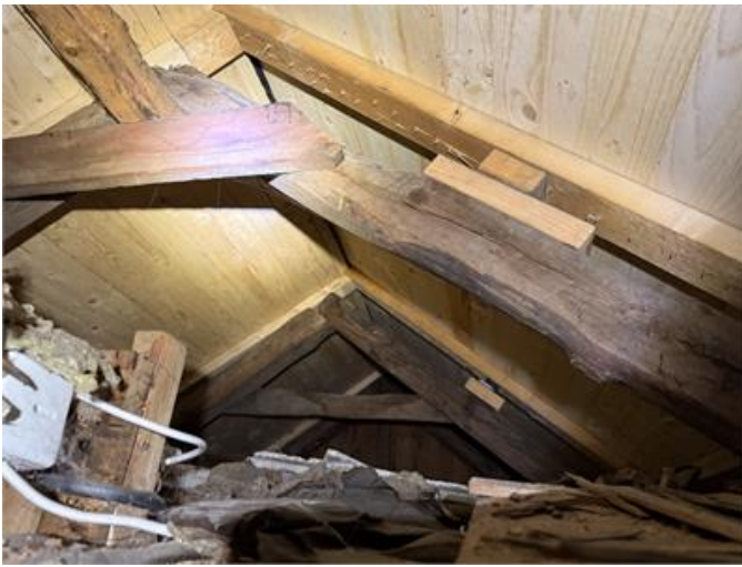
Råsponten är bytt på sadeltaket och taket förefaller vara riktat.
