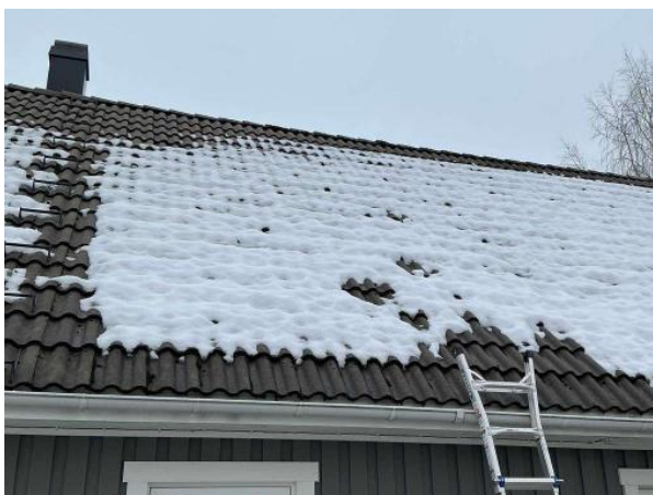
Bild 2: - Utvändigt, Yttertak, Taket är delvis snötäckt
