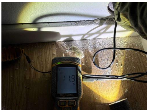
Bild 3: Invändigt, Betongplatta på mark, inga förhöjda fuktvärden noterades på en väggsyll i köket
