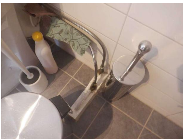
Bild 10: Rör i golv.
