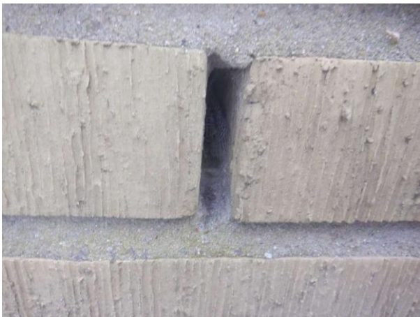
Bild 3: Nät saknas i stötfog.
