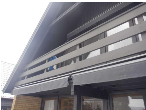
Bild 5: Balkongräckets utformning utan skydd.
