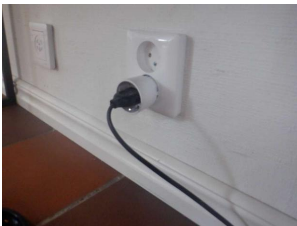
Bild 8: Ojordat el-uttag i utrymme med klinker.
