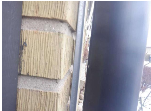
Bild 2: Fals vänd mot fasad.
