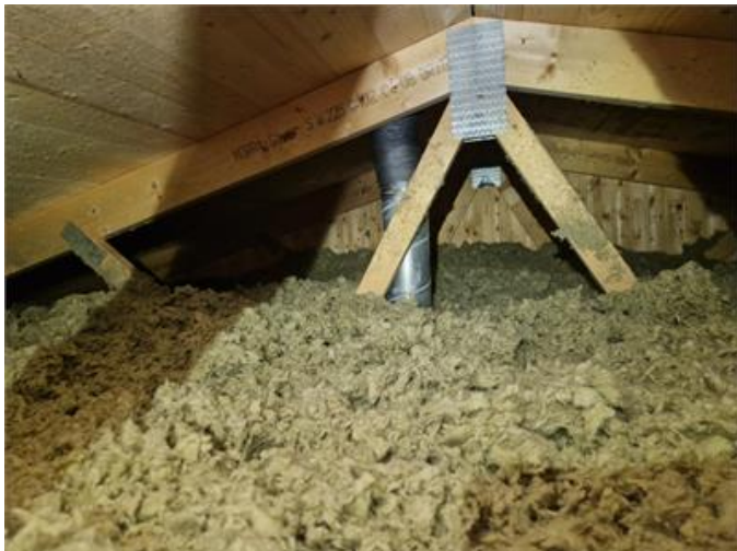
Vy på vindsutrymmet
