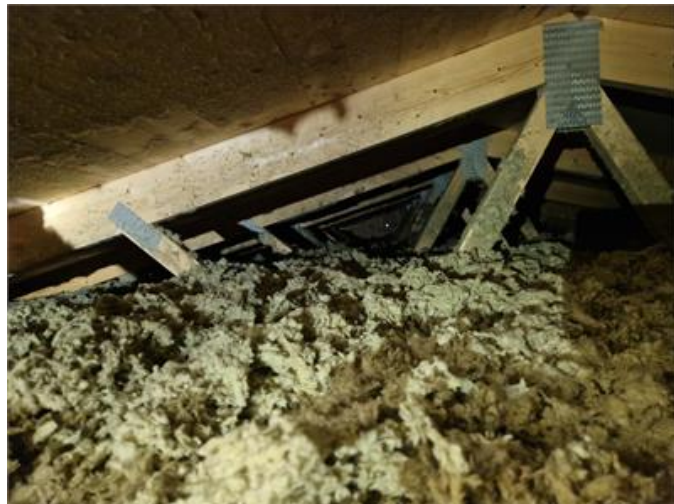
Vy på vindsutrymmet
