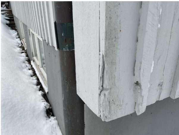
Bild 1: - Utvändigt, Fasad, Färgsläpp och torrsprickor noteras på panelen Delvis rötskada träpanel noteras
