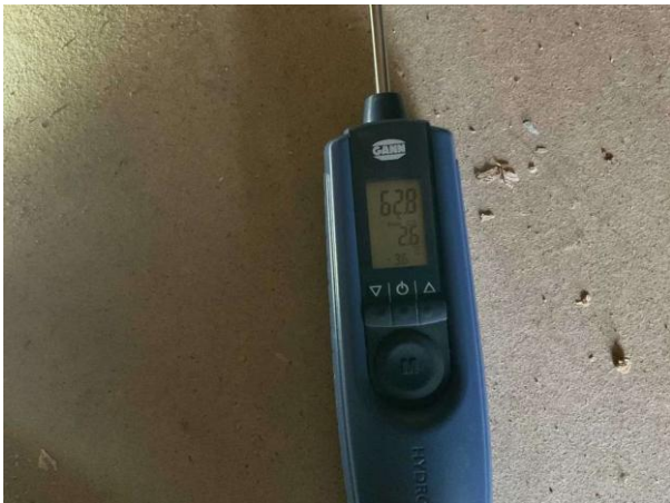
Bild 3: - Utvändigt, Vind, Fuktkontroll utförd se bilaga 4
