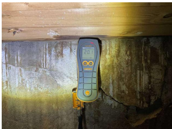
Bild 7: - Utvändigt, Vind, Fuktkontroll utförd se bilaga 4...
