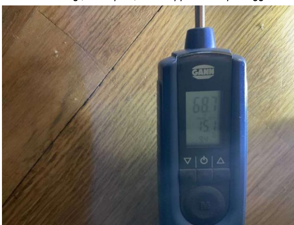
Bild 10: Invändigt, Källarplan, Fuktkontroll utförd se bilaga 4
