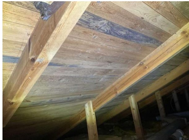
Bild 2: - Utvändigt, Vind, Lokalt på vinden noteras det mikrobiell påväxt samt fuktrosor på underlagstaket.
