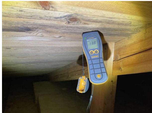
Bild 4: - Utvändigt, Vind, Fuktkontroll utförd se bilaga 4
