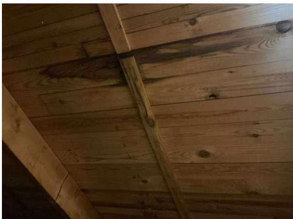
Bild 3: - Utvändigt, Vind, Lokalt på vinden noterades det mikrobiell påväxt på underlagstaket samt fuktrosor
