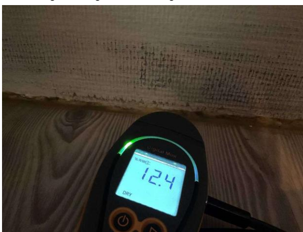
Bild 12: Invändigt, Entréplan, Fuktkontroll utförd se bilaga 4
