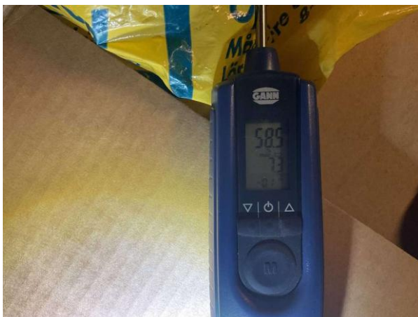
Bild 4: - Utvändigt, Vind, Fuktkontroll utförd se bilaga 4
