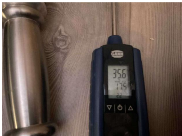
Bild 13: Invändigt, Entréplan, Fuktkontroll utförd se bilaga 4
