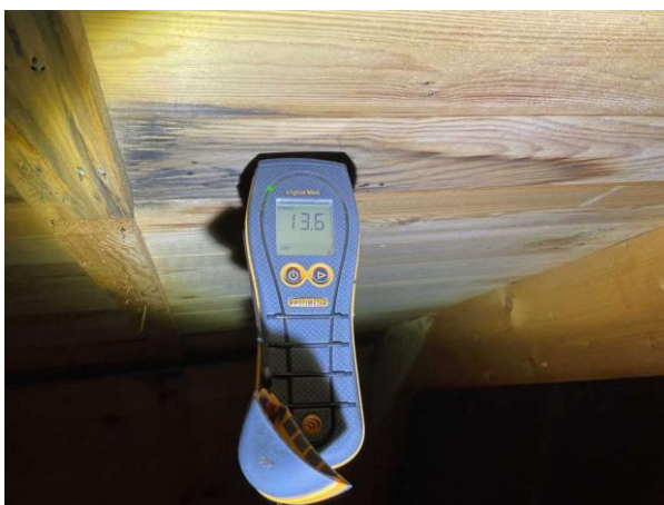
Bild 6: - Utvändigt, Vind, Fuktkontroll utförd se bilaga 4
