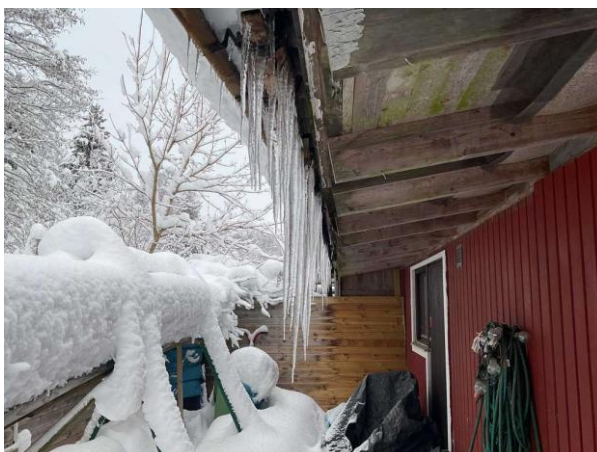
Bild 2: Utvändigt, Avvattning, Hängrännor saknas delvis
