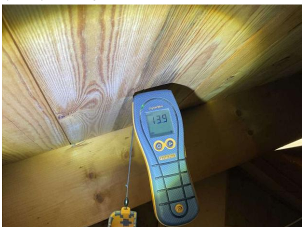
Bild 5: - Utvändigt, Vind, Fuktkontroll utförd se bilaga 4
