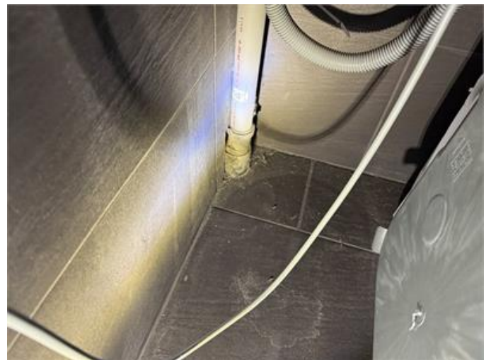
Avloppsrör placerad nära väggen (genomföring i golvet).
