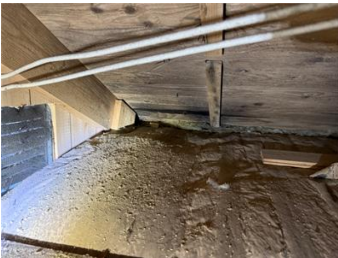
Mikrobiell påväxt förekommer på underlagstakets insida. Ett inläckage noterades också.
