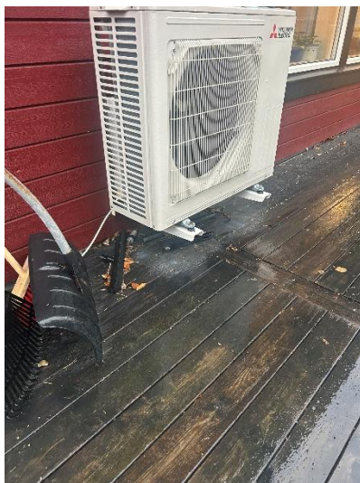
Spillvatten från värmepump.
