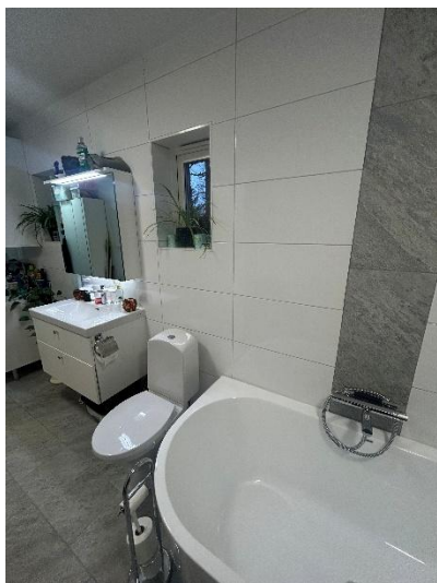
Fönster i våtzon 1.
