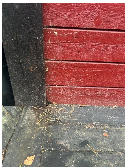
Spillvatten från värmepump.
