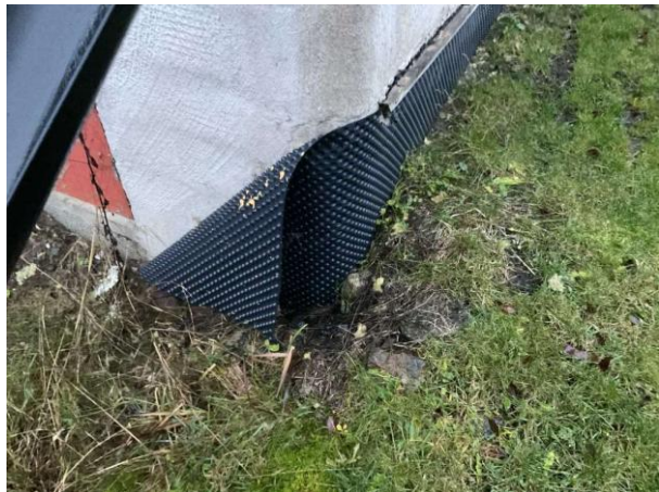
Bild 2: - Utvändigt, Grundmur/Hussockel, Platonmatta är synlig otät och saknar topplista
