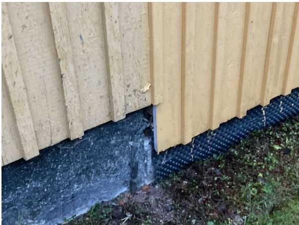
Bild 1: - Utvändigt, Grundmur/Hussockel, Färgsläpp och sprickor noteras på grundmurar otäthet noteras mellan byggnadsdelarna
