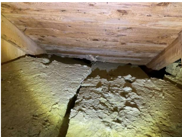
Bild 5: - Utvändigt, Vind, Huset är självdragsventilerat, se riskanalysen Vind är tilläggisolerad Bristfällig takfotsventilation.
