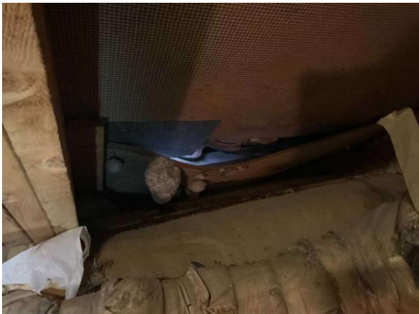
Bild 3: - Utvändigt, Vind, lös/hängande boardskiva, getingbo noteras på vinden
