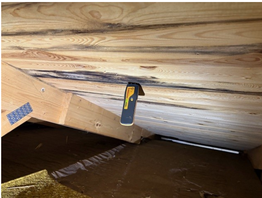
Fuktmätning på vind.
