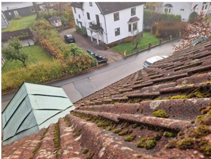
Vy på yttertak
