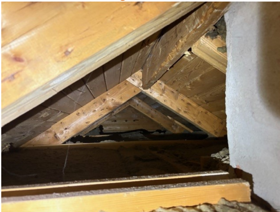
Nockvind via vindsluckan.
