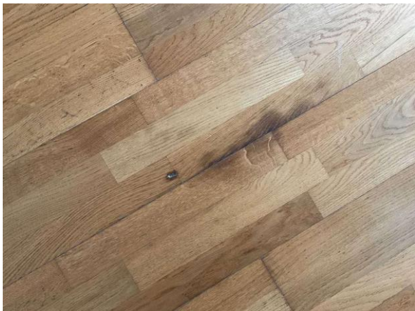
Bild 1: Invändigt, Entréplan, Missfärgning och mindre hål noteras på parketten
