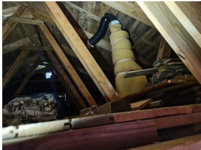
Vy på vindsutrymmet
