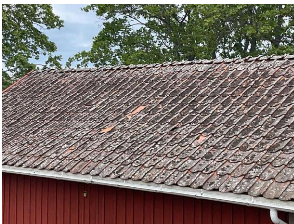
Bild 21: - Utvändigt, Yttertak, Äldre tak där det noteras trasiga pannor Fotplåt och nocktätning saknas
