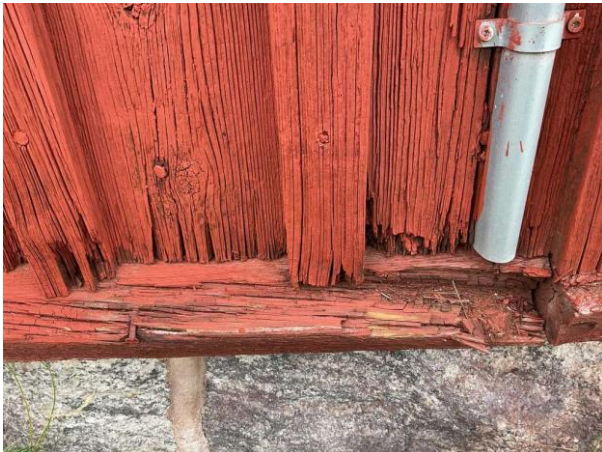
Bild 1: Utvändigt, Fasad, Färgsläpp och torrsprickor och delvis rötskadad panel noteras på fasaden, se riskanalys
