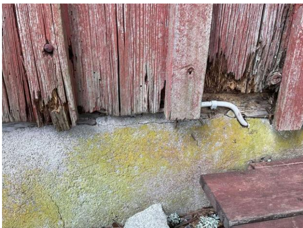
Bild 18: - Utvändigt, Fasad, Färgsläpp torrprickor och lokalt rötskadat träpanel noteras Synlig träsyll...
