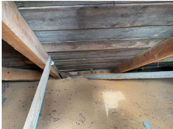
Bild 2: - Utvändigt, Vind, Huset är självdragsventilerat lokalt noteras det mikrobiellpäväxt på underlagstaket
