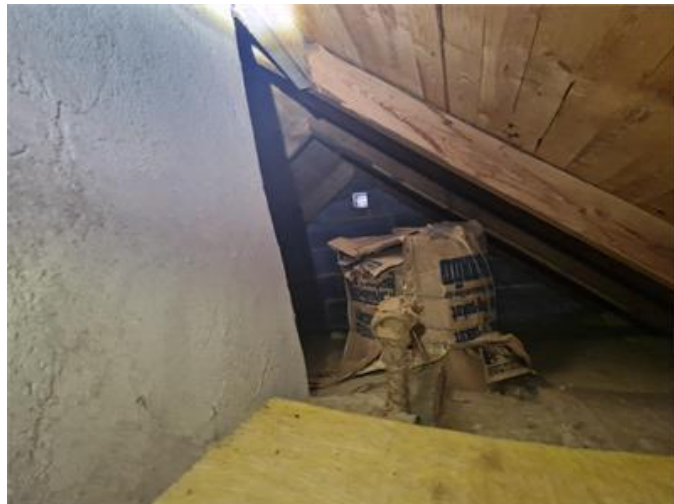
Vy på vindsutrymmet
