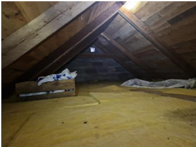
Vy på vindsutrymmet
