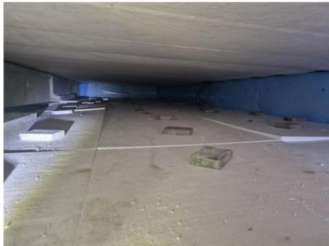
Vy i krypgrund
