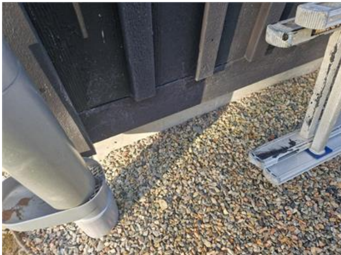
Nedre del av fasad/horisontell bräda som bör skyddas
